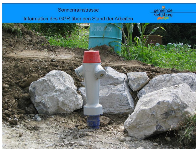
Die Wasseranschlüsse sind vorgenommen worden und funktionieren bereits wieder.
