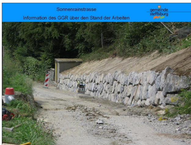
Neu erstellte Stützmauer. Die Kanalisationsarbeiten sind abgeschlossen und das Strassenfundament angebracht.
